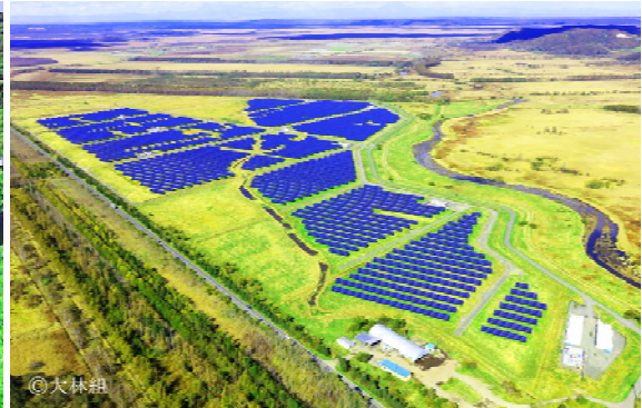
「短周期出力変動緩和対策を講じた大型蓄電池システムの導入」の設備
